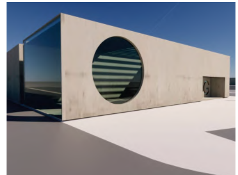
Condomínio Industrial – OGCL Arquitetos: Saraiva & Associados Pedra Angular
