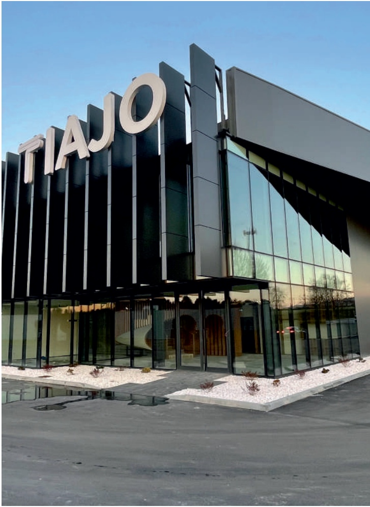
Novas instalações da TIAJO
