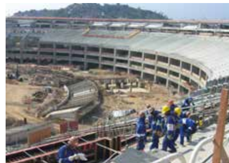
Obra do estádio do Maracanã
