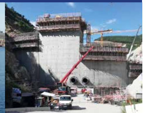
Central e Barragem do Tâmega
