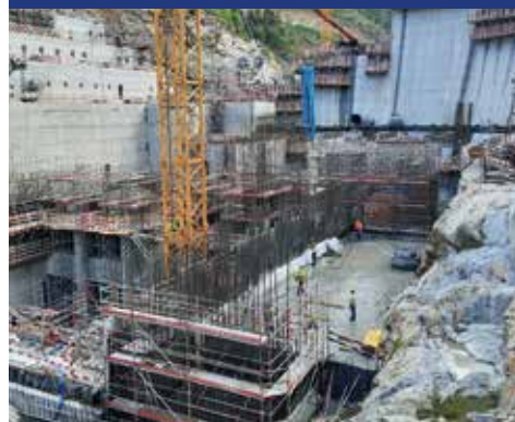
Central e Barragem do Tâmega
