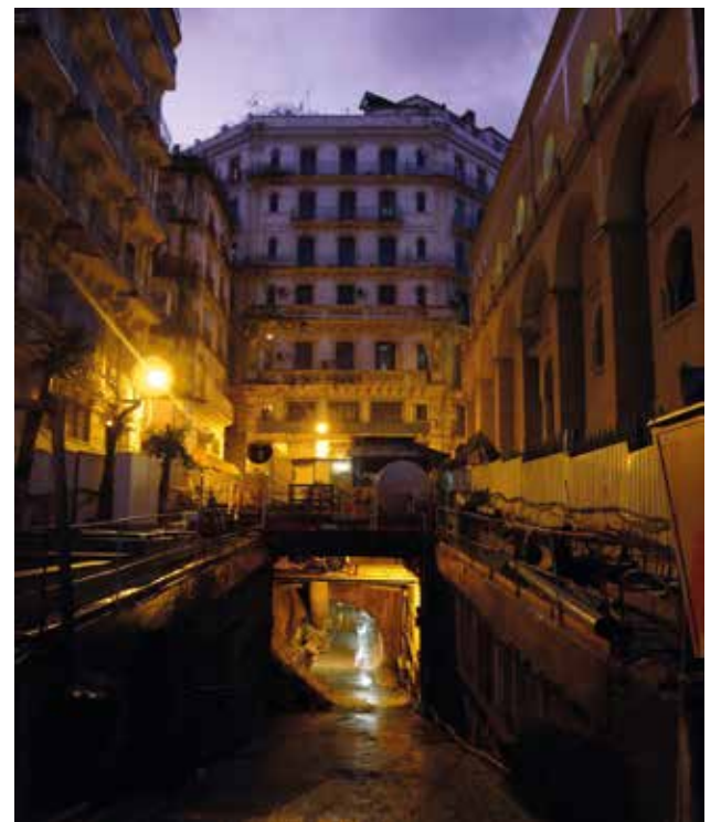
Acesso da Estação Ali Boumendjel usado como ataque à estação, o que exigiu passar a grande proximidade das fundações de um edifício de grande porte
