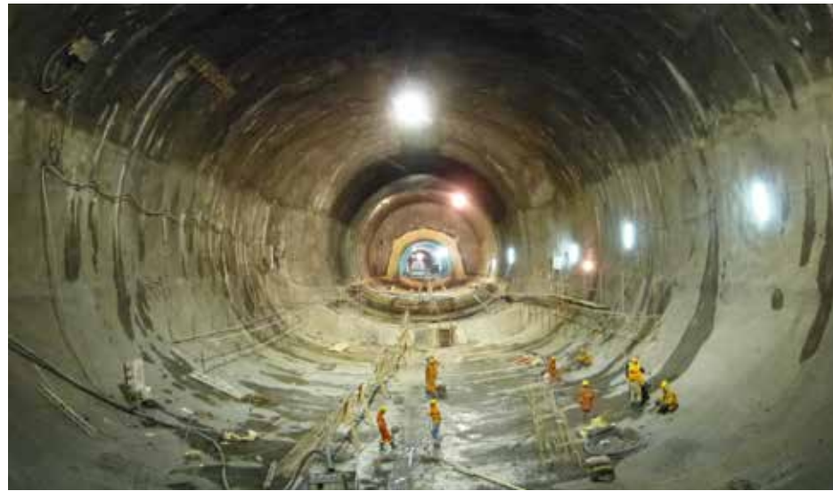
A grande galeria da Estação Place des Martyrs executada sob os milenares achados arqueológicos
