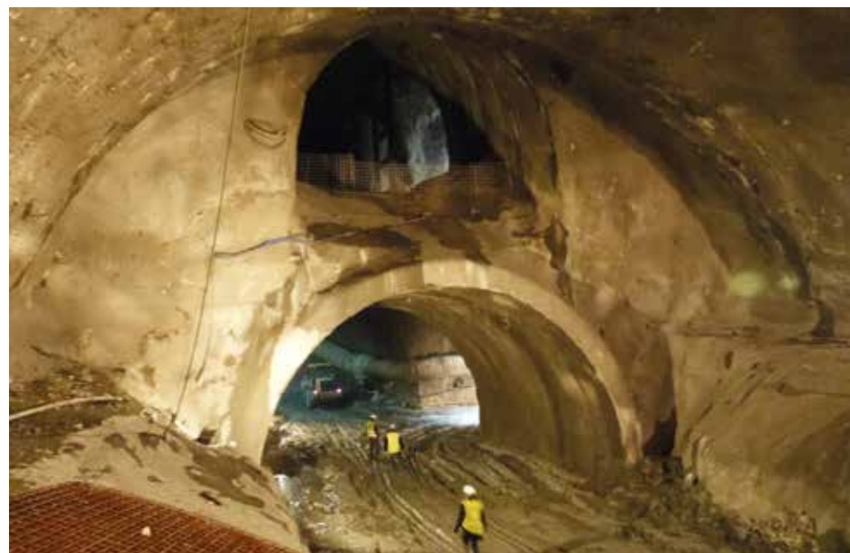
Topo Sul da Estação Ali Boumendjel onde é clara a confluência de várias escavações subterrâneas
