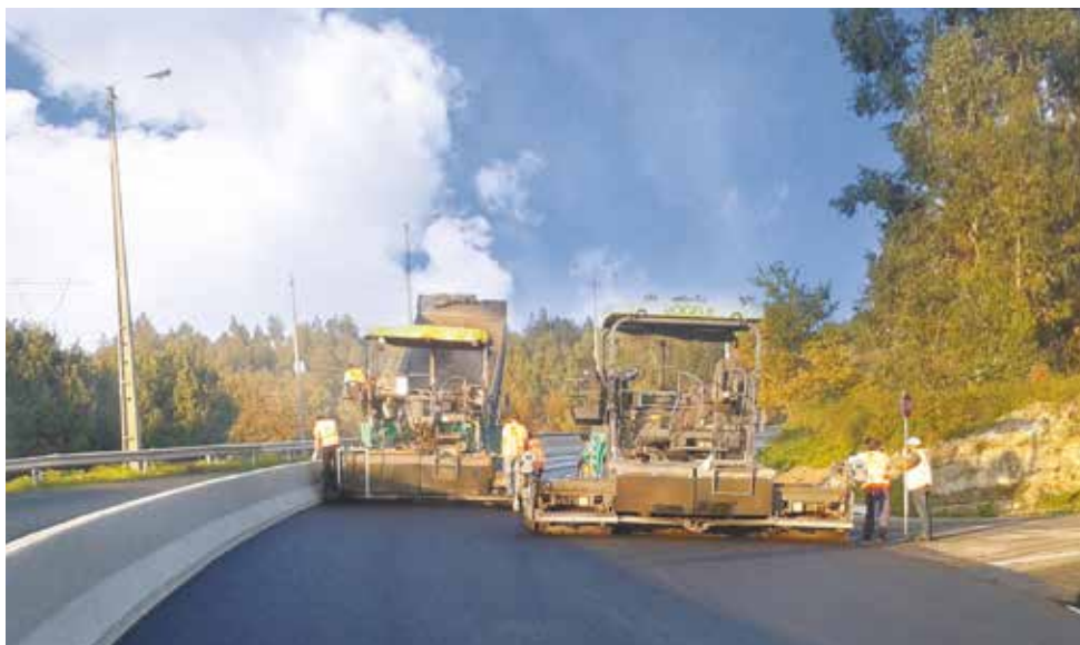
Projeto de construção rodoviária - Portugal
