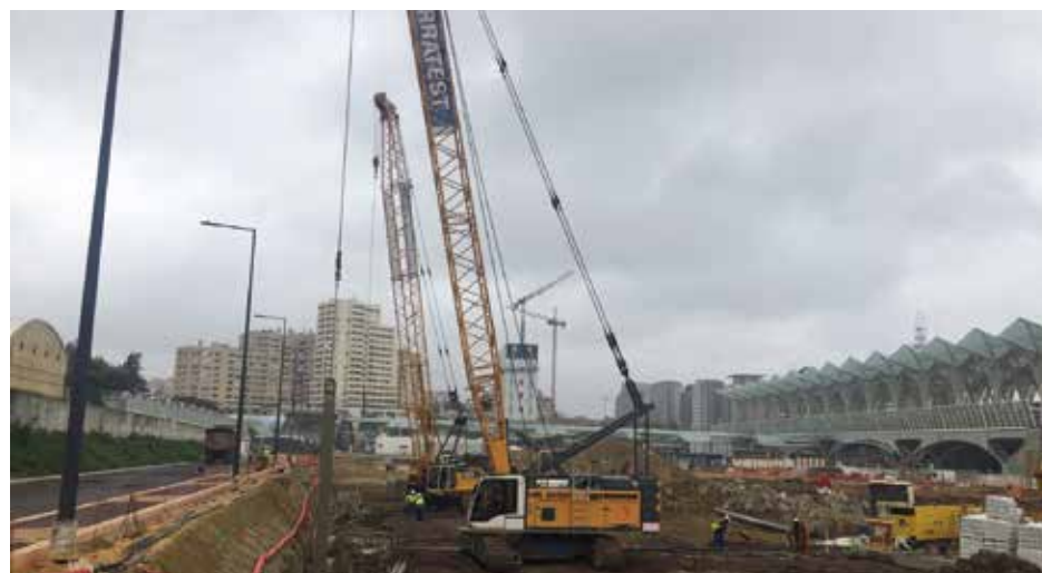
Obra EXEO – Lisboa – Paredes Moldadas
