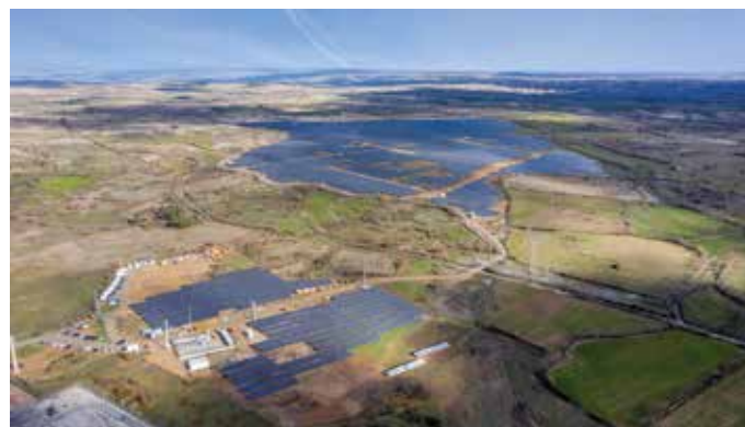
Central Solar Fotovoltaica em Mogadouro
