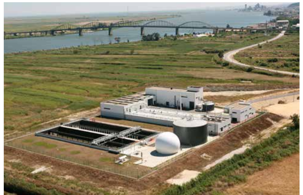
Fábrica de Água de Vila Franca de Xira
