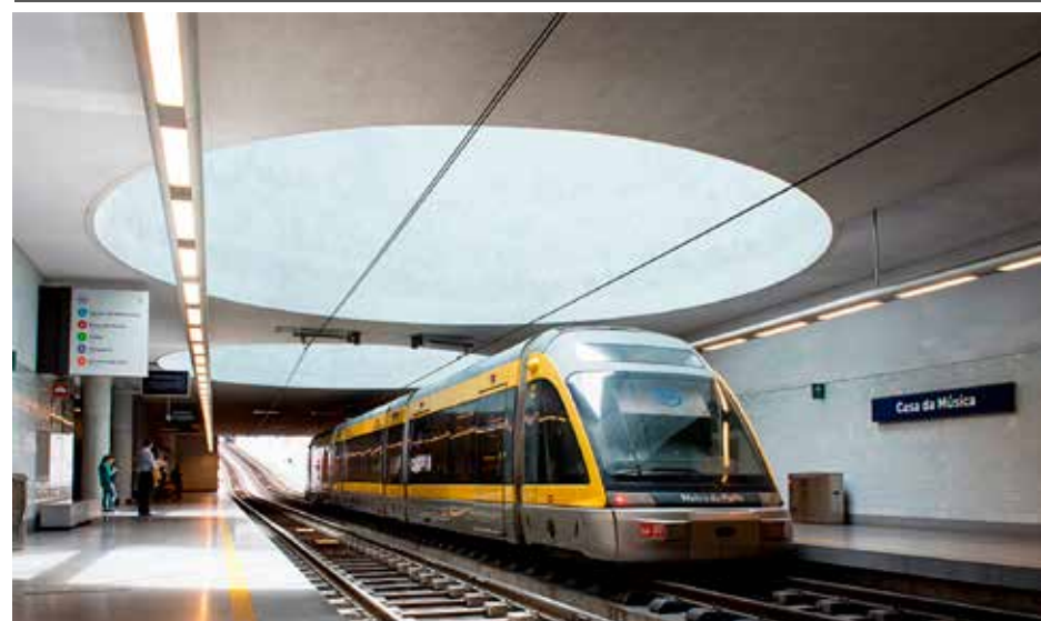
Extensão do Metro do Porto: Linha Rosa (Casa da Música – São Bento) e Linha Amarela (Santo Ovídio - Vila D'Este) 2 Grandes Projetos PO SEUR aprovados pela Comissão Europeia - Contribuição Fundo de Coesão: 107.000.000,00 €
