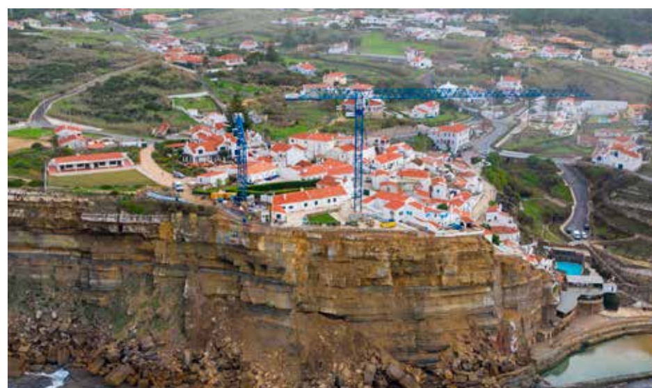
Minimização do risco nas arribas das praias do Magoito, Azenhas do Mar e S. Julião Projetos PO SEUR - Contribuição Fundo de Coesão: 3.044.112,55 €
