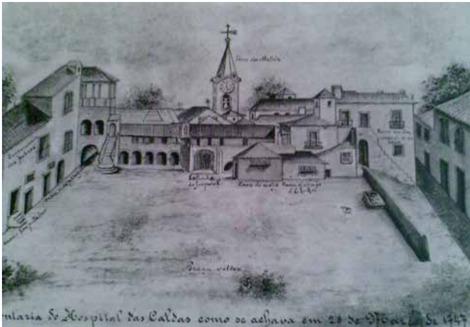
Hospital Termal das Caldas da Rainha
