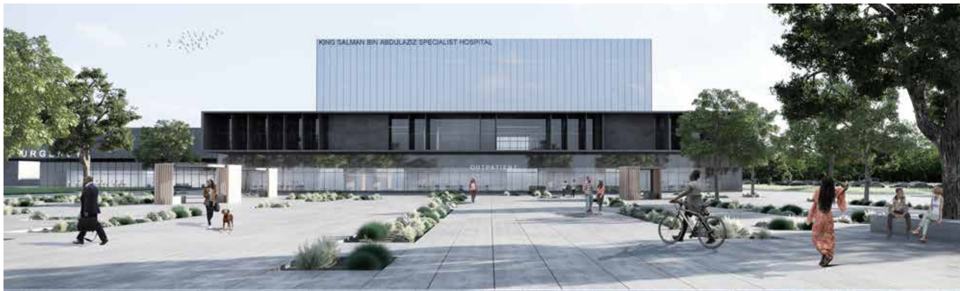
Hospital Materno-Infantil em Lusaka, Zâmbia (projecto concluído)
