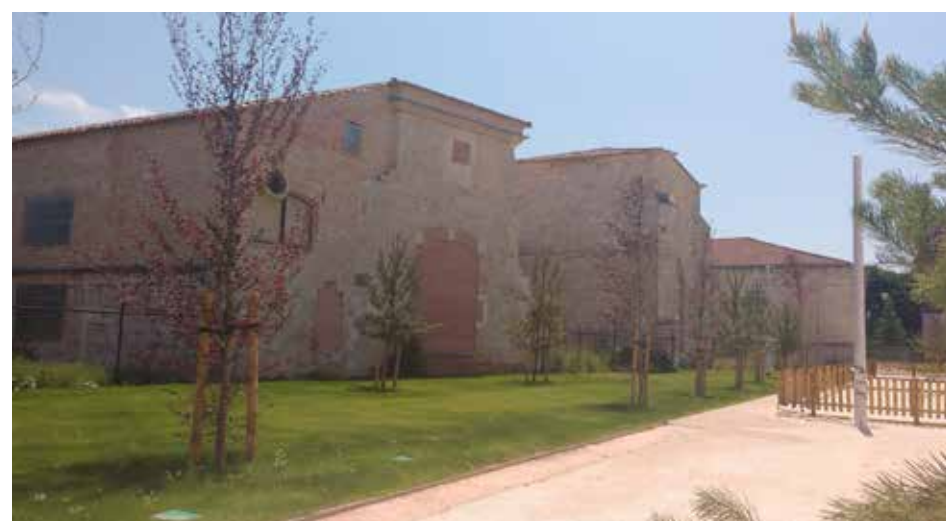
Hospital de la Concepción Burgos
