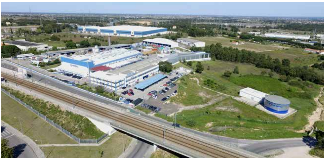
Vista Aérea das Instalações - Palmela
