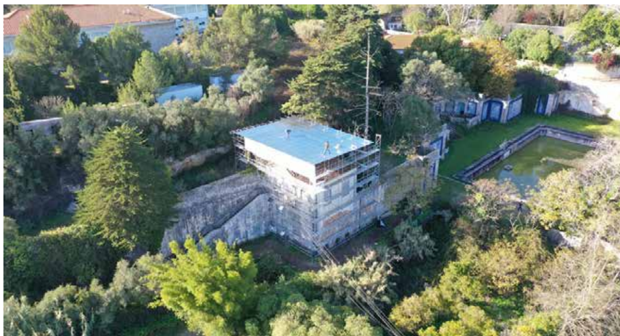
Obras de conservação preventiva na casa da Pesca
