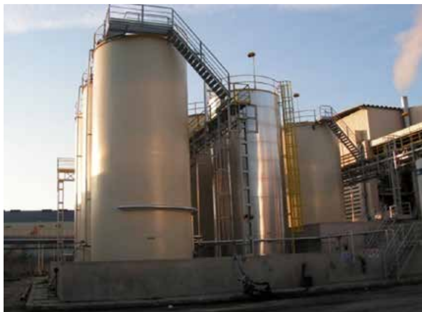
Reservatórios de Biodiesel Iberol
