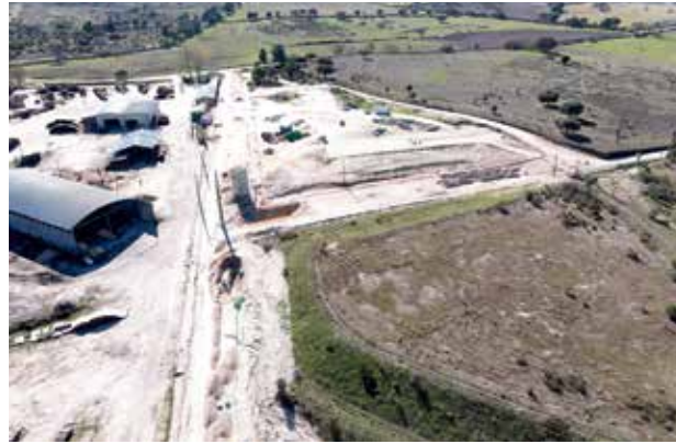
Nova Zona Industrial de Castelo de Vide
