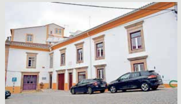
Obra do Lar João José Le Cocq da Santa Casa da Misericórdia de Castelo de Vide
