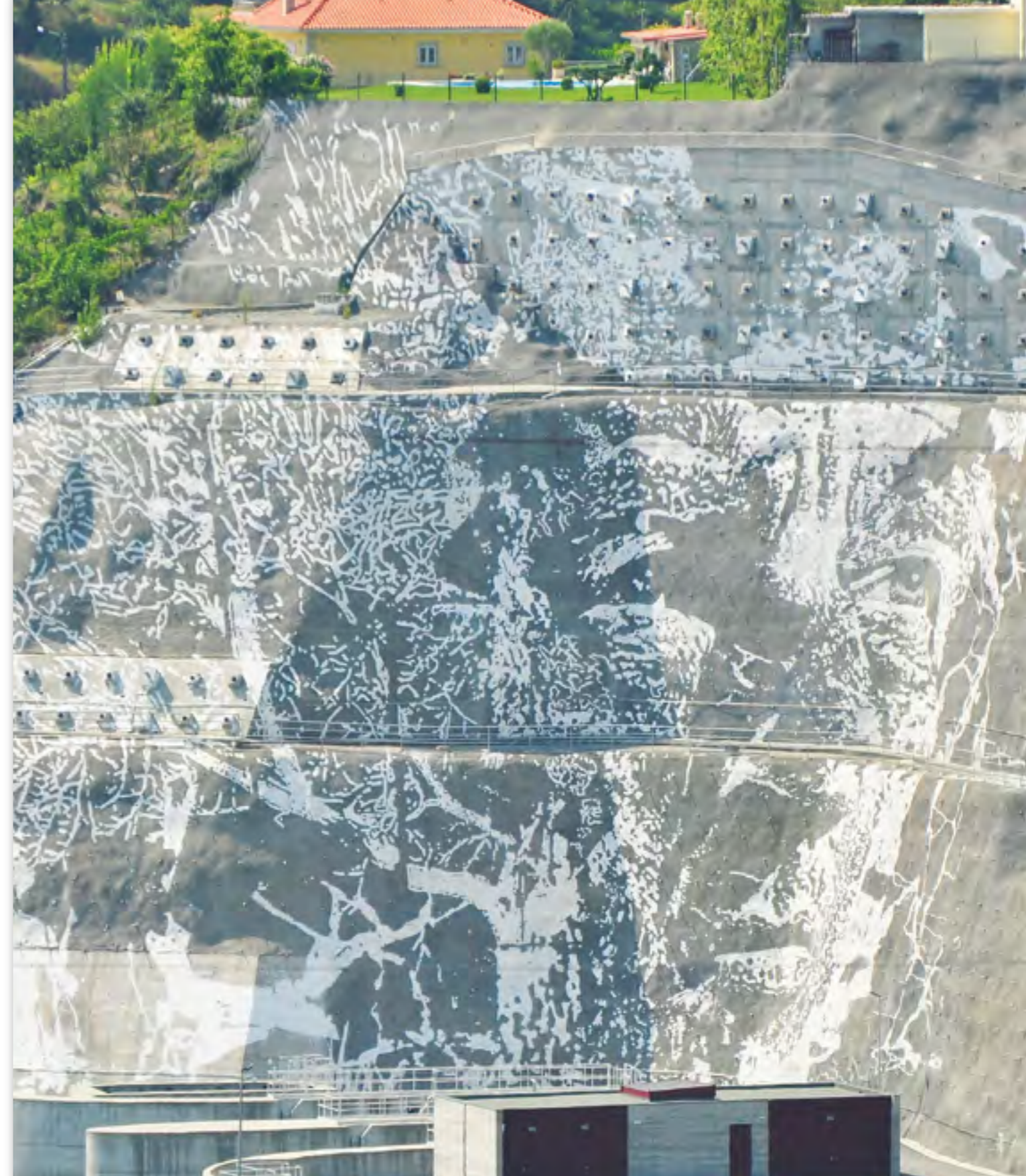
"Visceral", por Vhils, na Barragem da Caniçada (Vieira do Minho), visto da margem direita do Rio Cávado (Terras de Bouro). Pretende homenagear a resiliência da população local face ao êxodo rural e mostrar o diálogo entre o homem, o edificado e a natureza envolvente.
