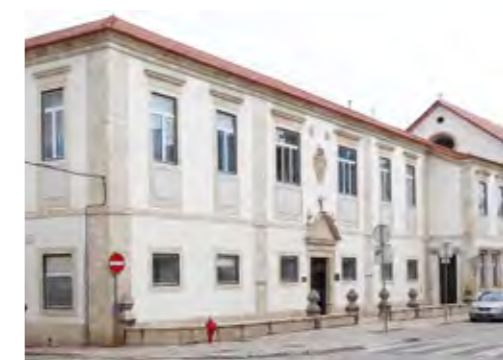
UNIDADE DE CUIDADOS CONTINUADOS DE LONGA DURAÇÃO E MANUTENÇÃO E IGREJA
